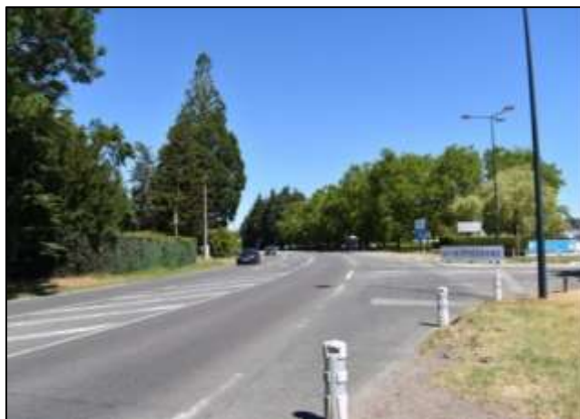
Figure 69 – RD6 permettant l'accès au centre omnisport et au CREPS depuis le sud (source : ECO-STRATEGIE, le 10/07/2019)
