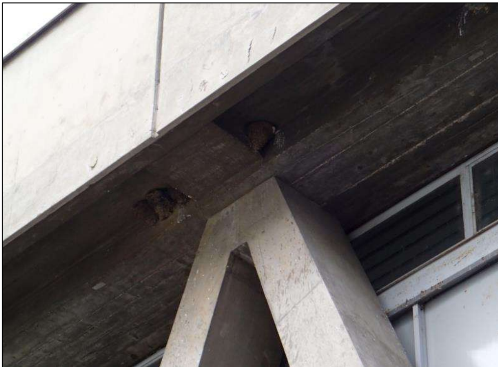
Figure 49 – Nids d'Hirondelle de fenêtre au niveau de la colonie installée sur le gymnase de musculation/danse du CREPS (source : ECO-STRATEGIE, le 09/07/2019)
