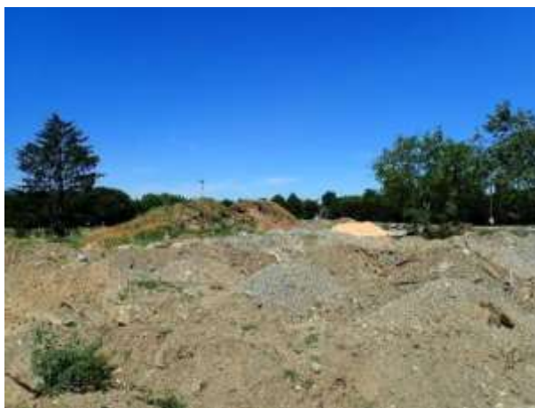
Photographie 2 – Remblais au sud-est du complexe de la boucle des Isles (ECO-STRATEGIE, 10/07/2019)
