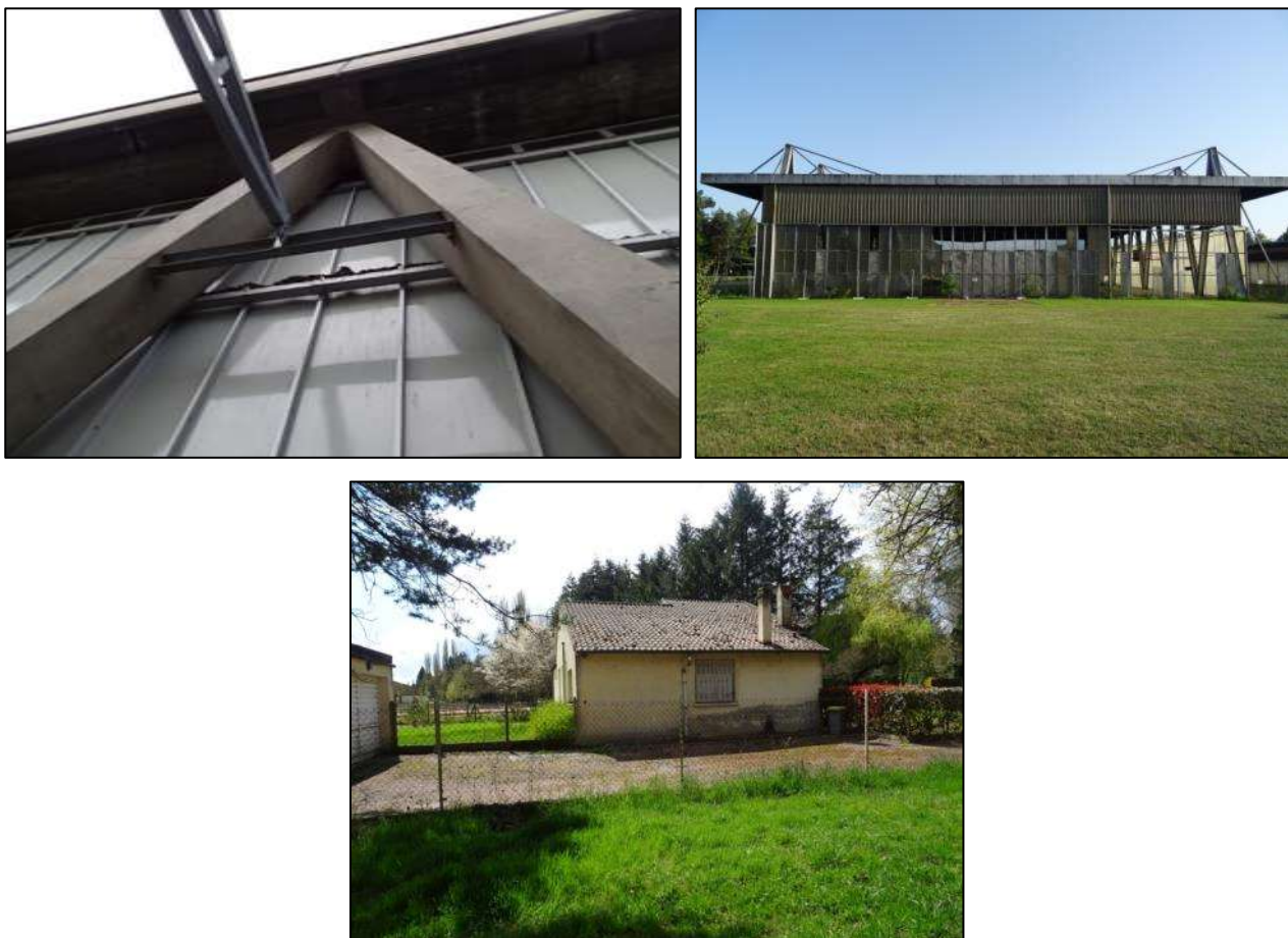
Figure 47 – Exemple de type de bâtis constituant le cortège anthropique : rives de toit et poutres métalliques du gymnase GTS du CREPS en haut à gauche ; hangar incendié ouvert du CREPS à rives de toit (et structure métallique interne favorable non visible ici) en haut à droite et maison individuelle au niveau du nord-ouest du centre omnisport
