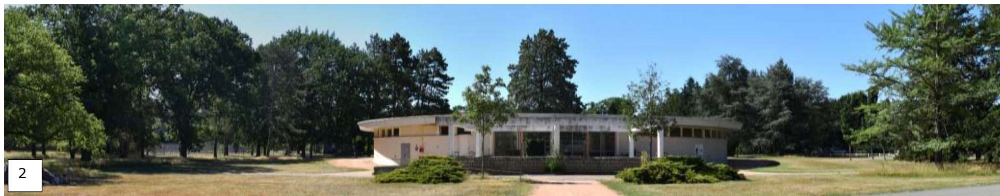
Photographie 12 - Point de vue depuis le centre omnisport, en direction du sud. (ECO-STRATEGIE, le 10/07/2019)
